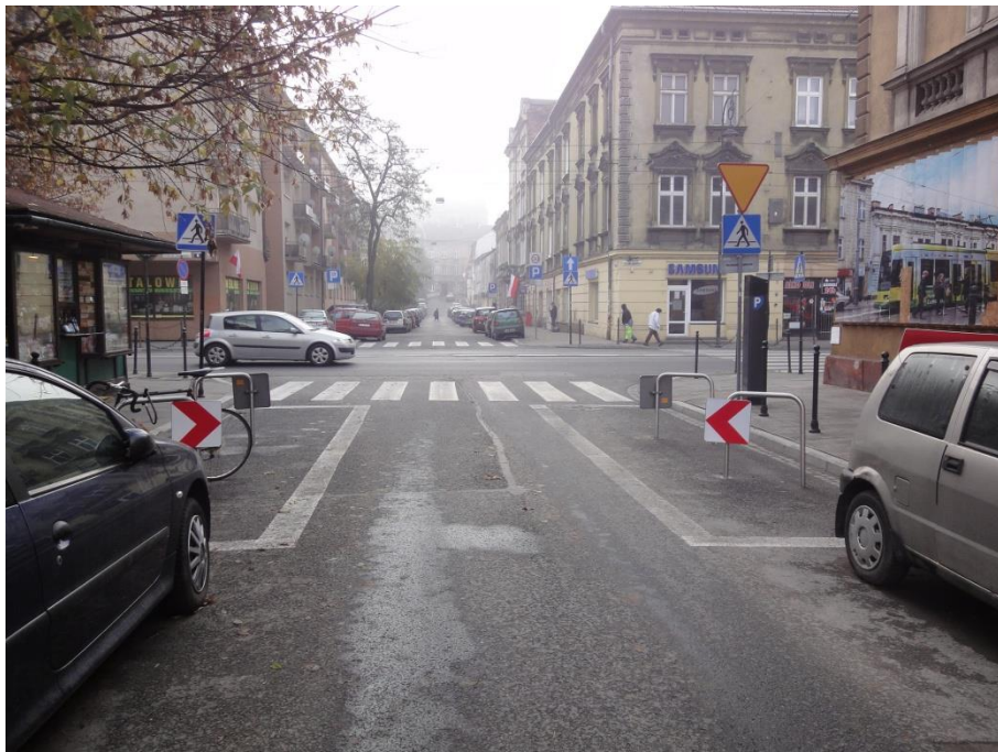
Zdjęcie 5.4 Przykład stojaków rowerowych zamontowanych przed skrzyżowaniem w Krakowie Źródło: własne
